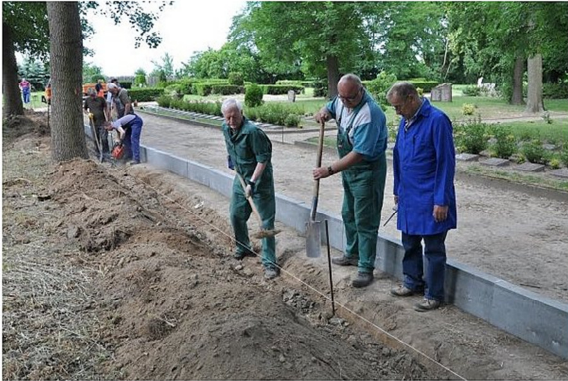
Die Reservisten aus Bremervörde und Nauen setzen für den Weg an der Kriegsgräberstätte Borde und werden ihn mit Recyclingmaterial befestigen. | Foto: Andrea Schröder
